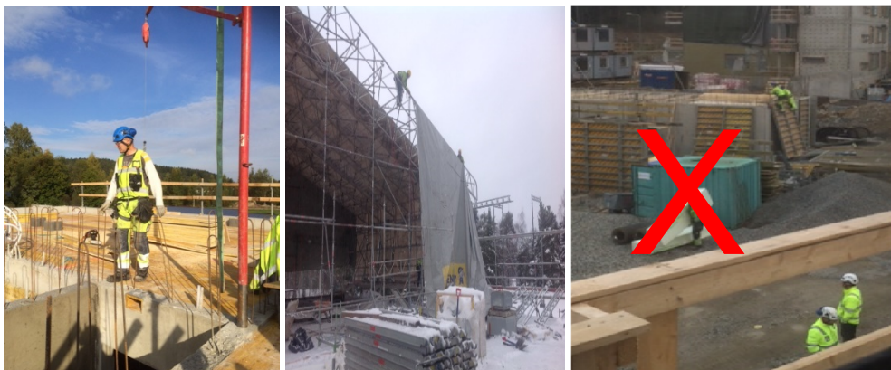
Kuvat. Hyviä käytäntöjä ja putoamisvaarallinen työtapa (reunimmainen kuva oikealla)
