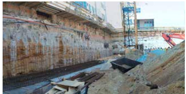
Perustusten vahvistusta rakennuskaivannon vieressä
