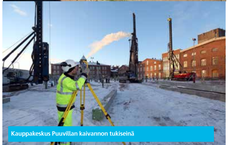
Linnanpellon alueen esirakentaminen
