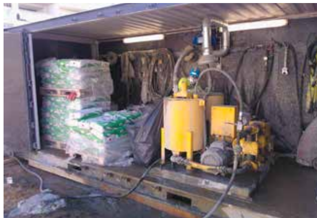
Käytämme nykyaikaista Atlas Copco A-C Unicrout Mini Flex-laitteistoa. Injektointiasema on varustettu rekisteröintilaitteella, joka tallentaa injektointitiedot raportointia varten.
