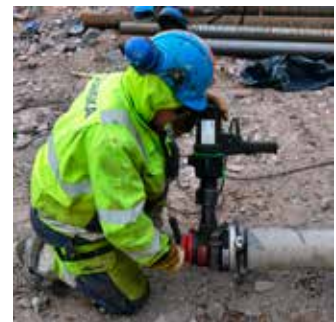
Kalustomme kuuluu mm. yllä kuvassa oleva Hütte 609 -poravaunu. Alakuvissa putkipaalu ja Skanskan työntekijä viisteyttämässä putkipaalu työmaalla.
