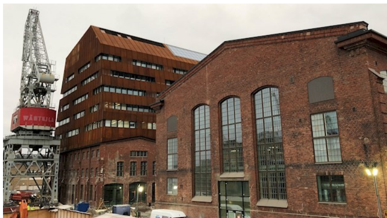
Vanhan Konepajahallin suojeltu julkisivu on korjattu entiseen loistoonsa. Kuva: Tuomo Jaakkola.
